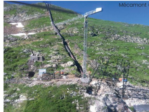
Funiculaire de l'usine Portillon permettant d'acheminer des charges en altitude
